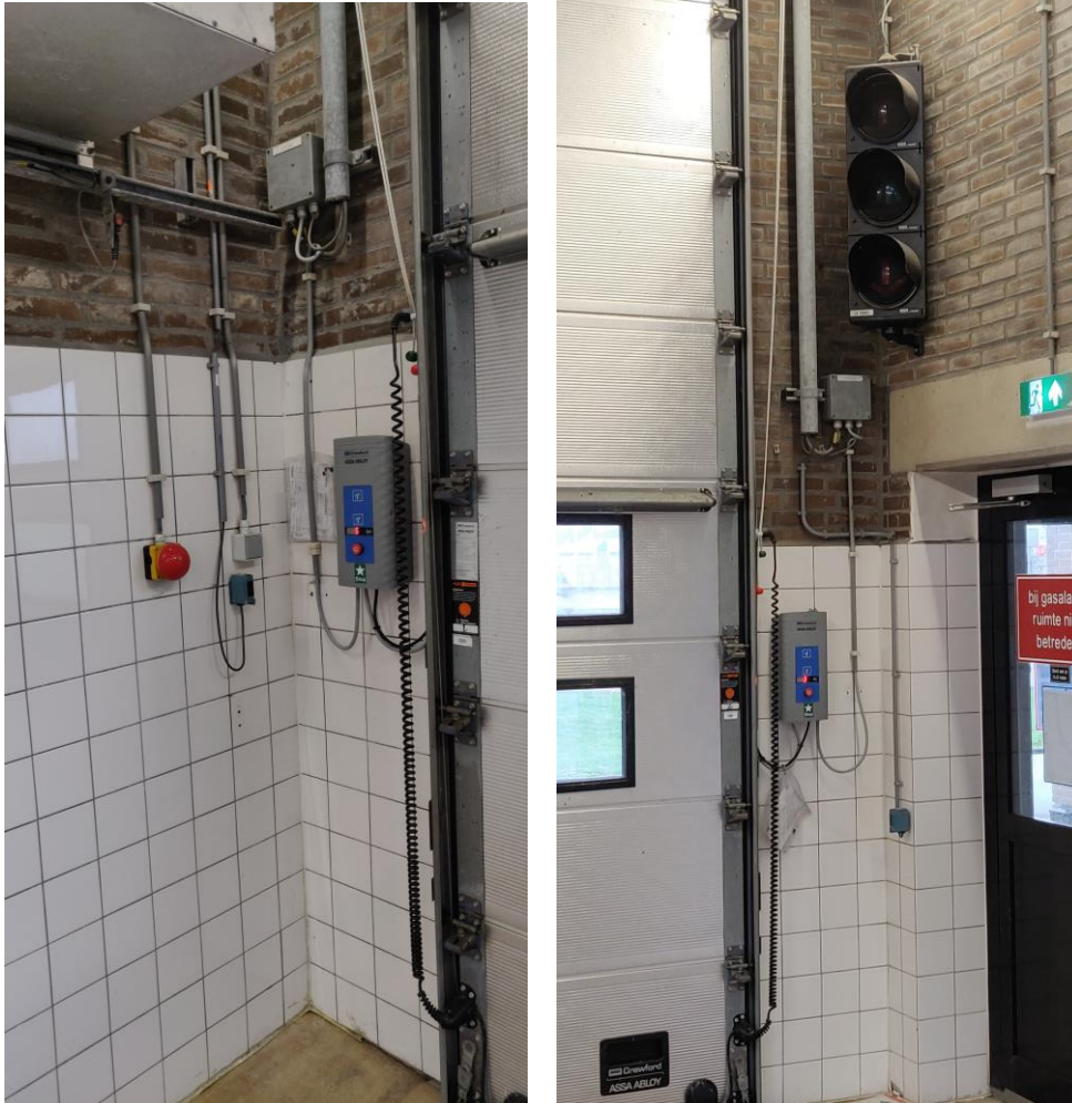
Afbeelding 2.1 Lokale bediening roldeuren, inrij (links) en uitrij (rechts)
